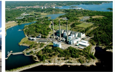
E.ON, Karlshamn, S, 174 MWth
